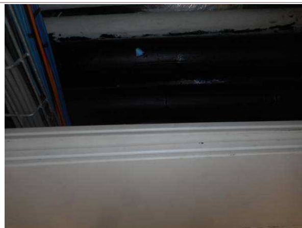
Photo n° 141 / prélèvement n° 141 A : Enveloppe de calorifuge B : Isolant Bâtiment principal, 1er étage, circulation local gaine technique
