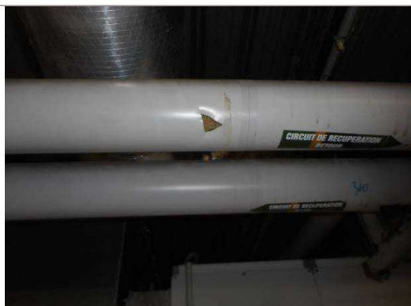
Photo n° 108 / prélèvement n° 108 A : Enveloppe de calorifuge B : Isolant Bâtiment SMA, 1er étage, zone technique, réseau eau glycolée
