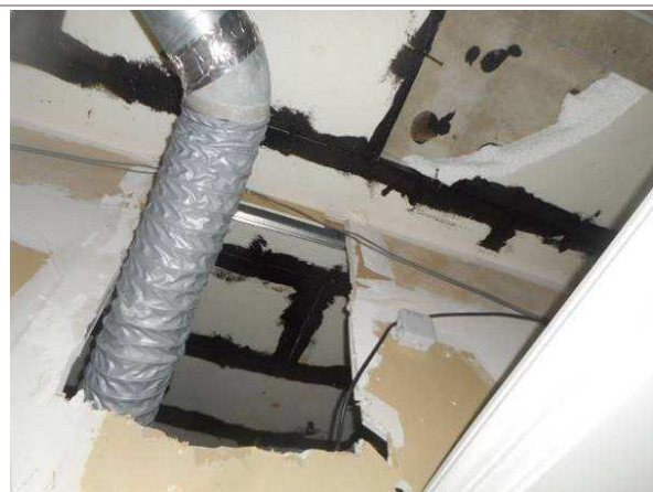
Photo n° 143 / prélèvement n° 143 A : Panneaux collés B : Colle bitumineuse Bâtiment principal, 1er étage, circulation
