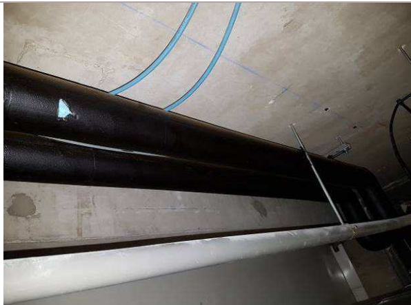
Photo n° 188 / prélèvement n° 188 Enveloppe de calorifuge bitumineuse Bâtiment principal, 3ème étage, laboratoire 3331, réseau d'eau glacée
