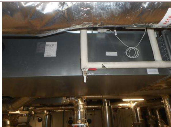
Photo n° 106 / prélèvement n° 106 Calorifugeage Bâtiment SMA, 1er étage, zone technique, réseau eau chaude chauffage
